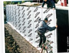
1, 2. Самоклеящиеся мембраны дороже наплавляемых материалов, но их стоимость оправдана высокой надёжностью в сочетании с быстрым и простым монтажом
