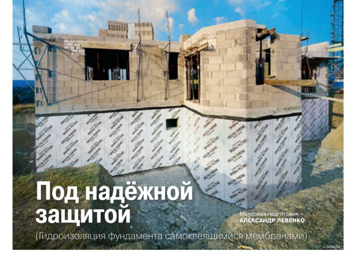
Фундамент – важнейшая часть здания, от которой зависит долговечность всего дома. Чтобы фундамент служил надёжно и долго, его необходимо гидроизолировать. Одно из современных решений для этого самоклеящиеся гидроизоляционные мембраны
