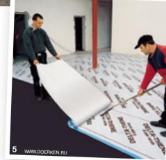
Процесс монтажа мембраны напоминает наклейку обоев, выполнить его способны даже рабочие, не имеющие высокой квалификации
